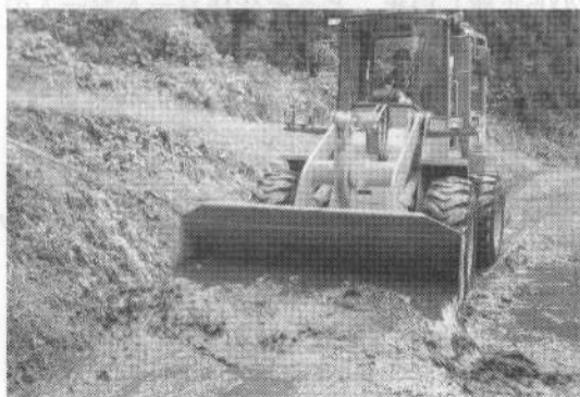
山崩れが土石流となり一部が宿の裏手まで流れてきた。ヘドロのようだった。
