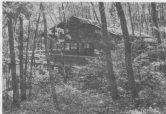
完成したナラ林の中の多目的ホール
