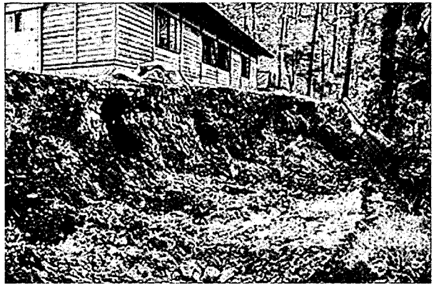
8月の大雨で崩れた敷地。自力で復旧することにした。
