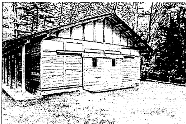
新築となった「ものづくり作業棟」。大工さんの仕事は骨組みだけ。内外壁はり、建具、床はり等はあぶらむの仕事です。
